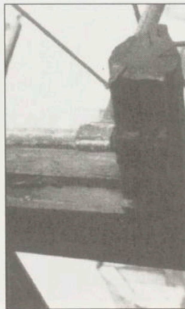
Détail de la construction découvert pendant les travaux
