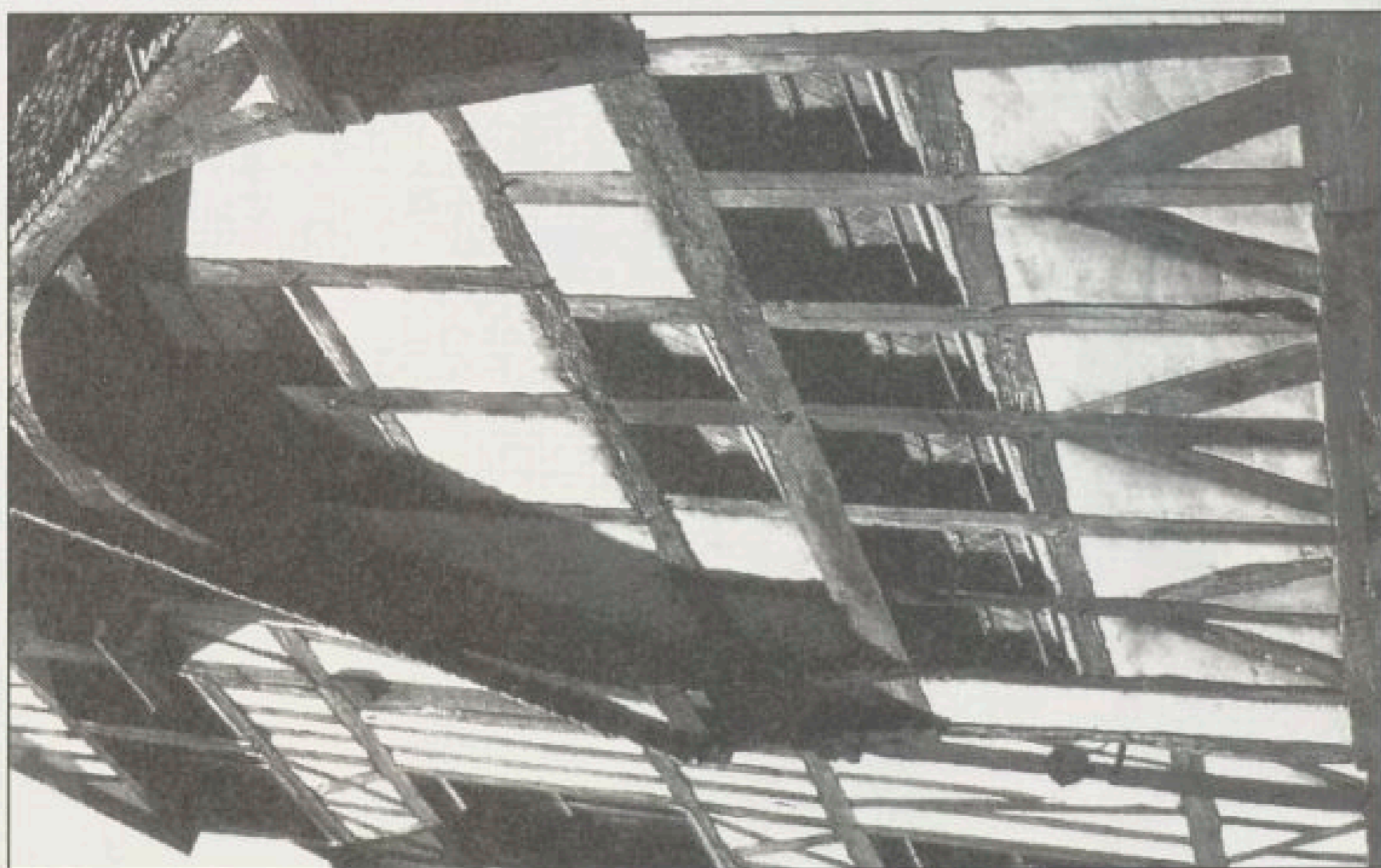
Maison de type archaïque (XVIIIème s.) - 39, rue Damiette
