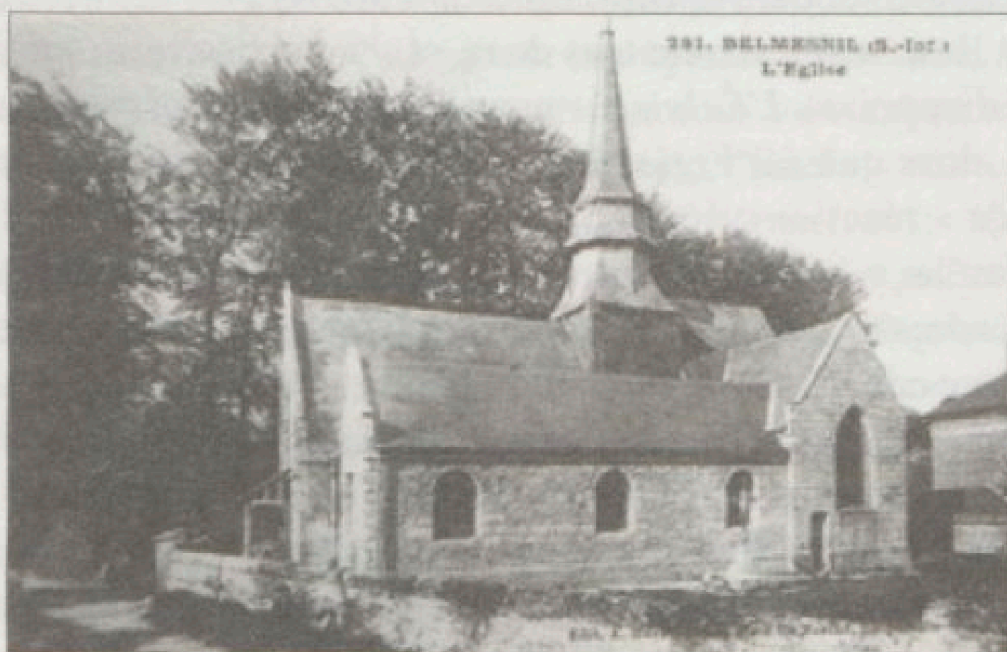
L'église de Belmesnil en 1920, avec sa nouvelle nef au premier plan.
