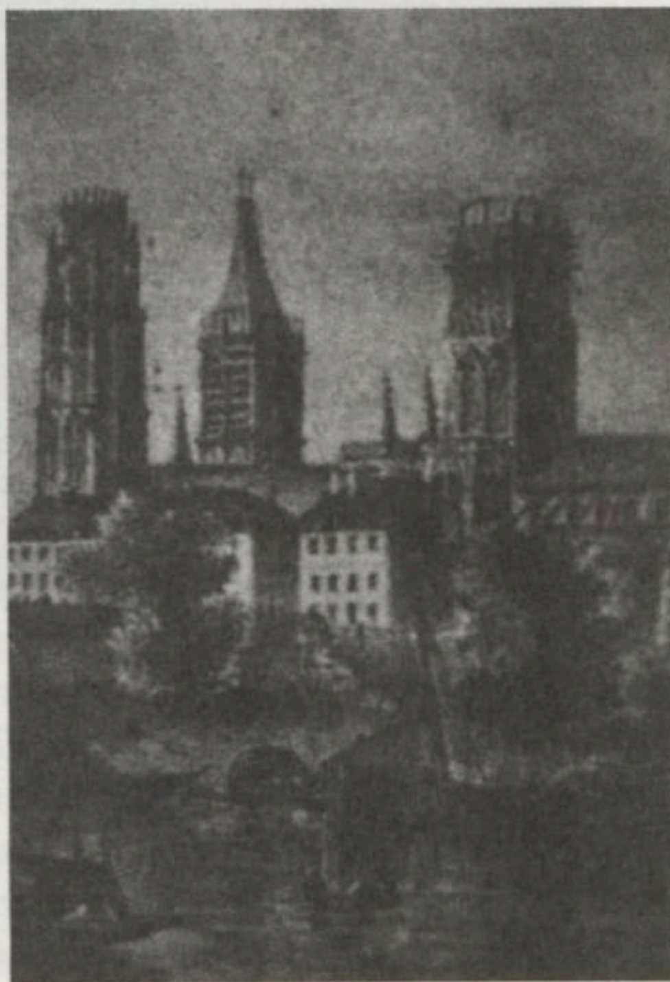
Premières protections de la Tour Lanterne
